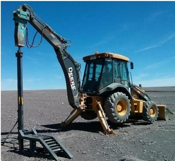
Figura 1-11. Hincado de perfiles para Proyectos fotovoltaicos
