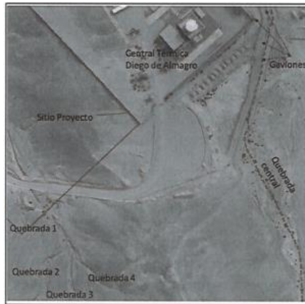
Figura N°2. Ortofoto instalaciones y existentes. Fuentes: Extraído de la Figura 14 de la Adenda en evaluación.
