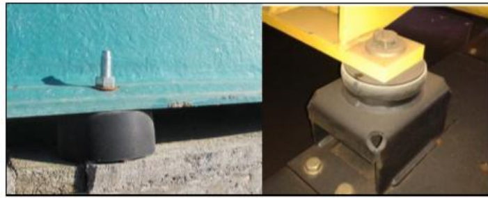
Figura 12. Anclaje con soporte antivibratorios.
