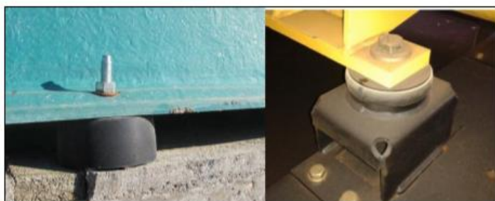
Figura 12. Anclaje con soporte antivibratorios.
