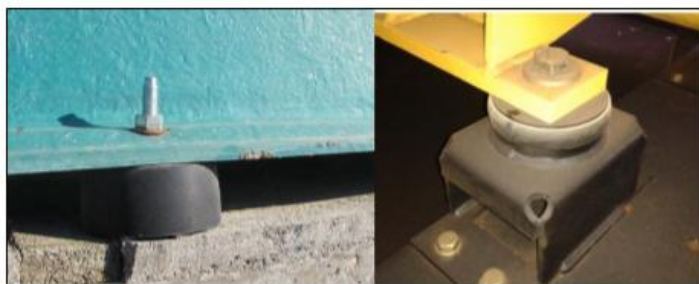
Figura 12. Anclaje con soporte antivibratorios.
