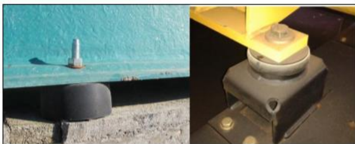
Figura 12. Anclaje con soporte antivibratorios.
