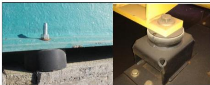
Figura 12. Anclaje con soporte antivibratorios.
