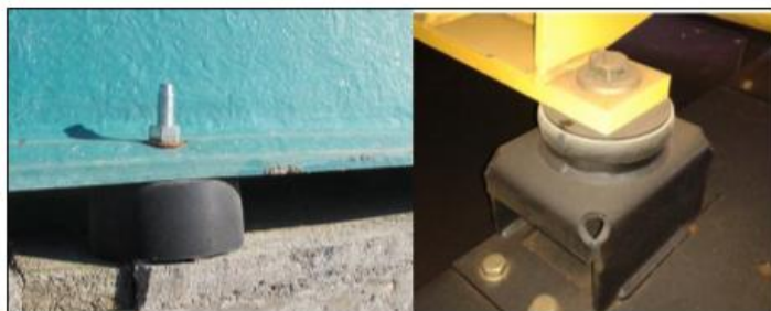
Figura 12. Anclaje con soporte antivibratorios.
