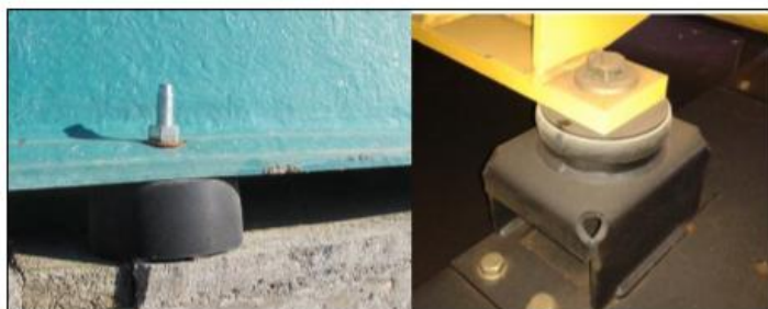
Figura 12. Anclaje con soporte antivibratorios.
