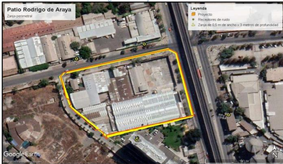
Figura 4: Zanja Perimetral (Fuente: Extracto informe de ruido y vibraciones adjunto en el Anexo AC-02 de la Adenda complementaria).
