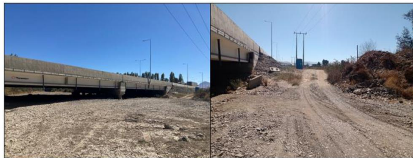
Figura 70. Sector Puente Estero Codegua en Ruta 5 Sur
