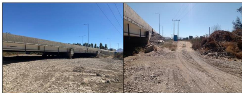
Figura 70. Sector Puente Estero Codegua en Ruta 5 Sur
