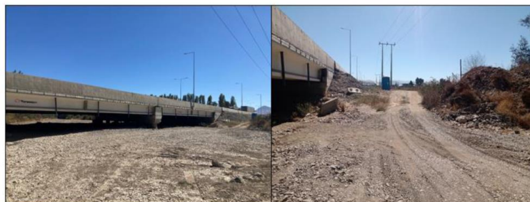
Figura 70. Sector Puente Estero Codegua en Ruta 5 Sur
