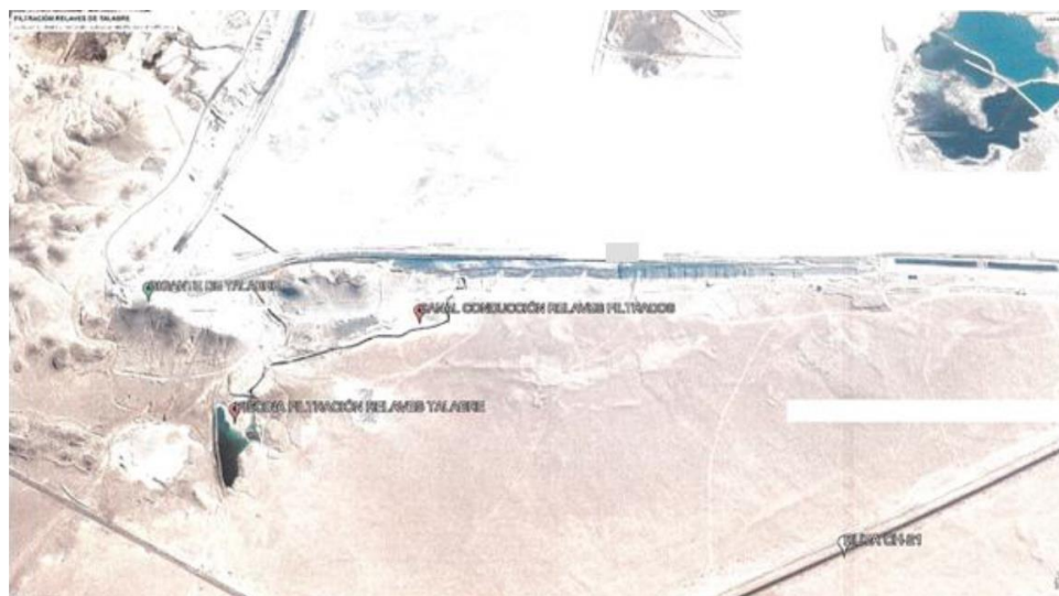
Figura 4-10: Piscina Filtración Relaves Talabre, 19 K 518559.04 E 7521364.87 S
