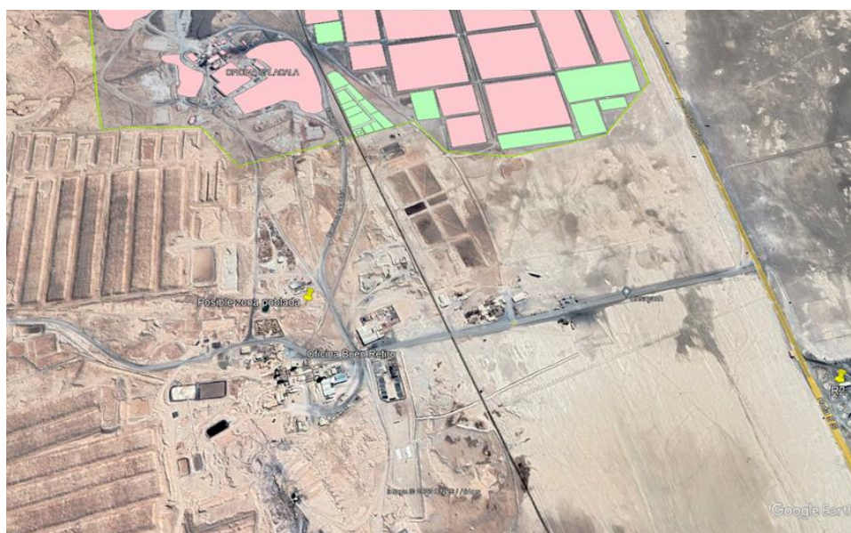
Figura 1. Oficinas y edificios cercanos al proyecto en ingreso por Ruta 5
