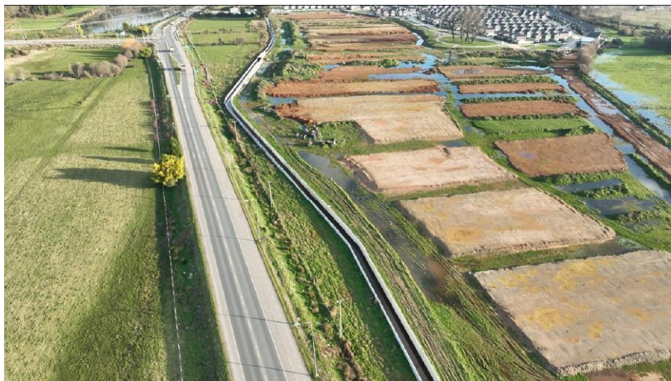
Figura N° 10: Vuelo DRONE (2 de agosto 2022), vista de Sur a norte del proyecto. Se observan rellenos y condiciones de humedal.
