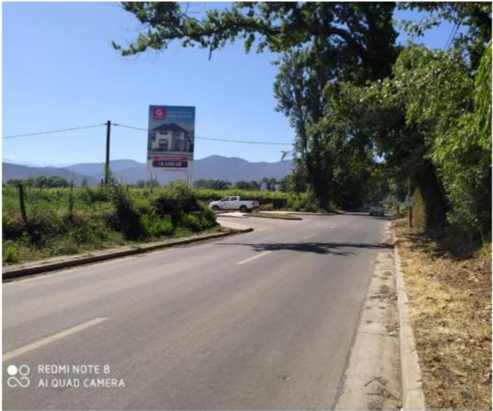
Figura 54. Situación actual Camino Las Rosas.
