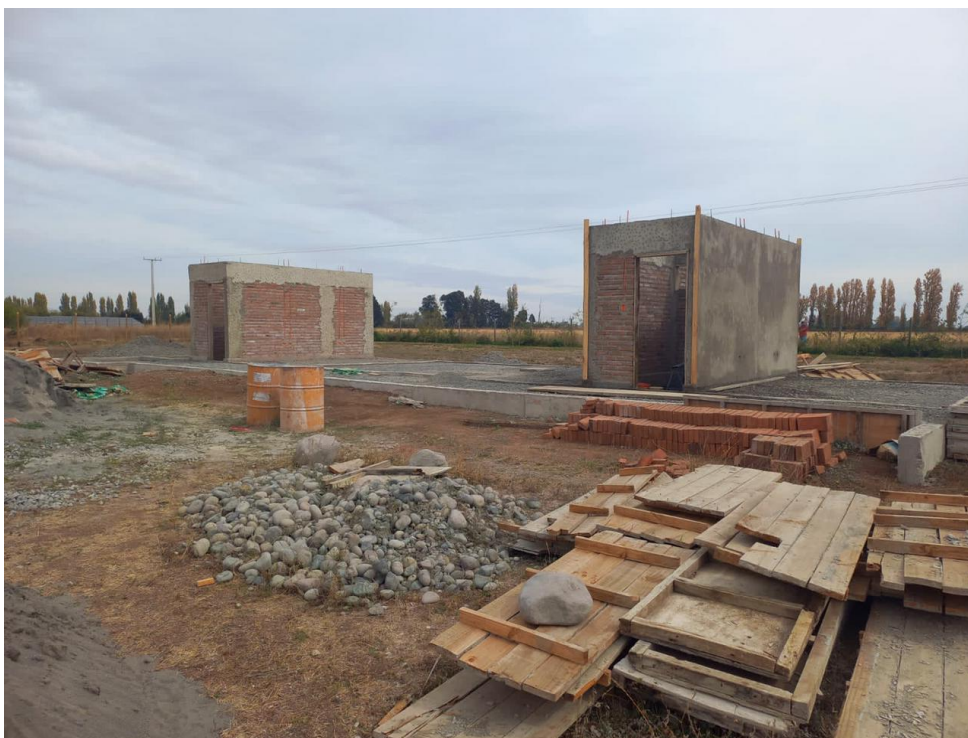
Fotografía 4: Construcción casa habitacional, sector la Gloria. Coordenadas Este 245915,94 Norte 5999286,79
