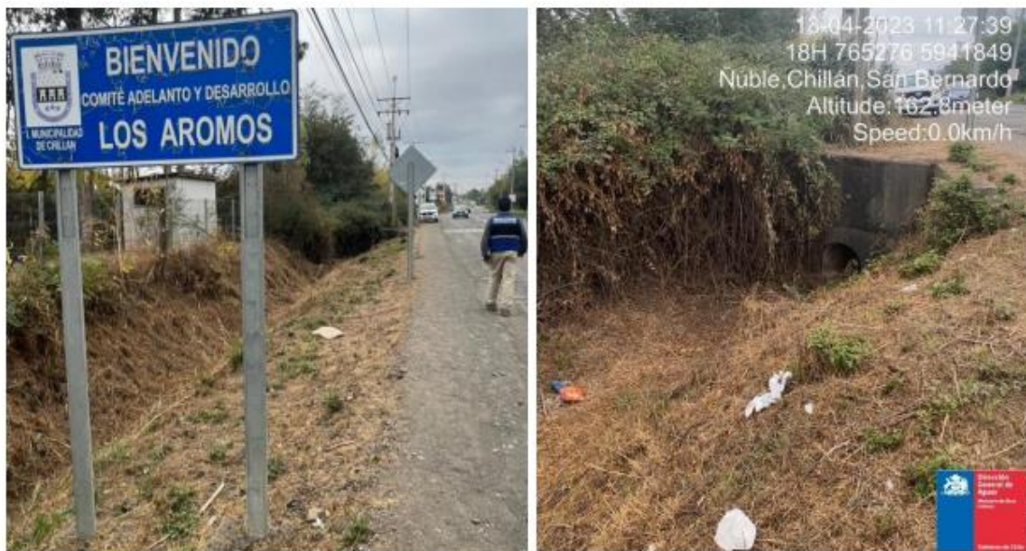
Imagen 3. Obras en tramo aguas arriba del proyecto.
