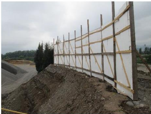
Fuente: Figura 19 “Imagen Referencial de Barreras Acústicas Modulares con Paneles OSB”, del Anexo 3.3 Ruido y Vibraciones Actualizado de la Adenda.
