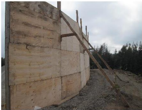
Fuente: Figura 19 “Imagen Referencial de Barreras Acústicas Modulares con Paneles OSB”, del Anexo 3.3 Ruido y Vibraciones Actualizado de la Adenda.
