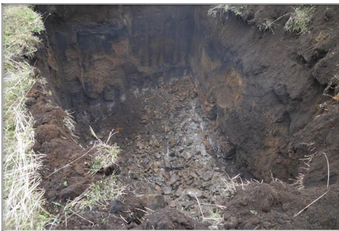
Figura N° 32. Fotografías excavación en área del proyecto.
