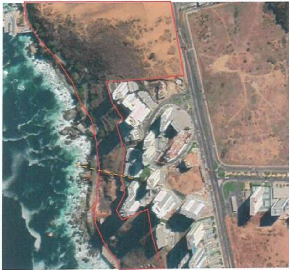
Imagen 10: Fragmentación de terreno, excavación genera un gran impacto en la geomorfología y un daño irreparable al paisaje y ecosistema. Marzo 2020.
