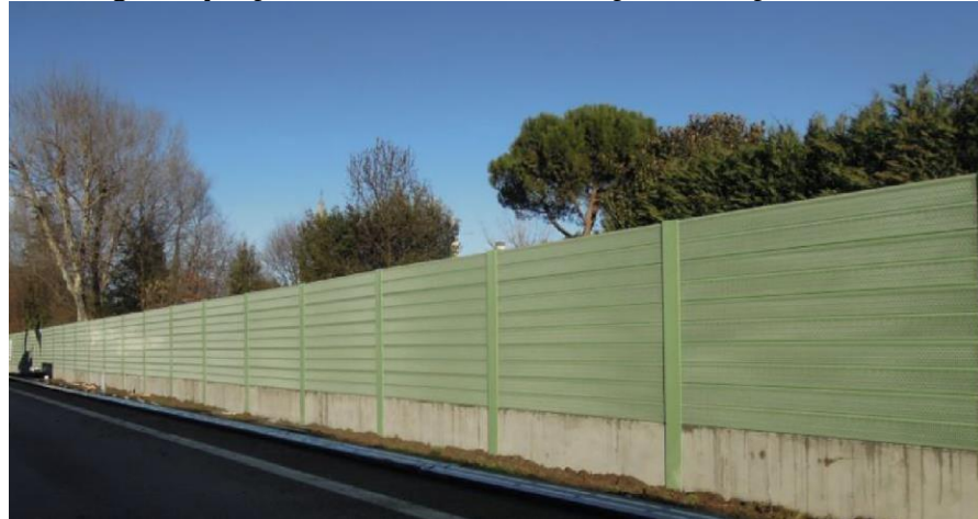
Figura: Ejemplo de barrera acústica semiperimetral permanente.
