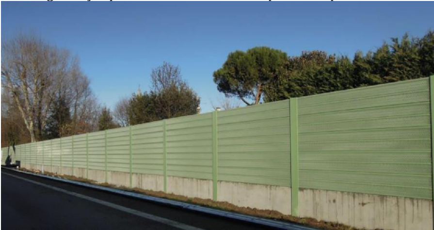
Figura: Ejemplo de barrera acústica semiperimetral permanente.
