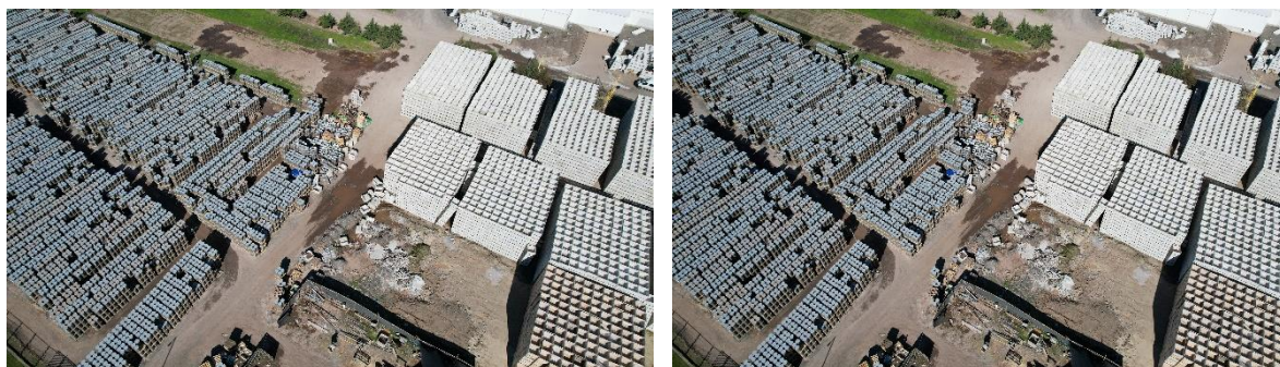
Imágenes 1 y 2: Sector contenedores Metálicos en mal estado
