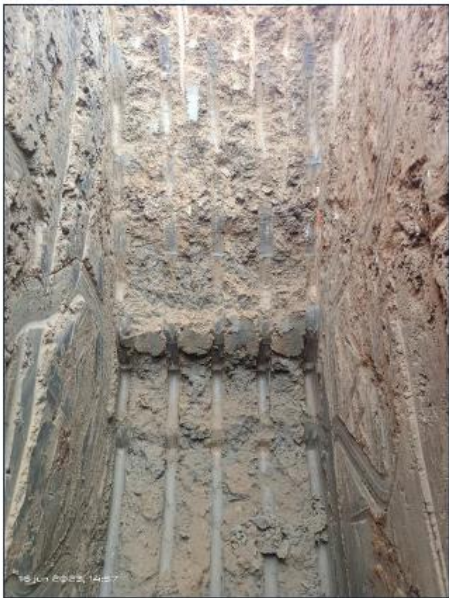
Fondo y paredes calicata secas Fecha: 16-06-2023
