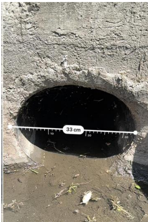
Fuente: Fotografías de visita a terreno, de fecha 24 de octubre de 2023.
