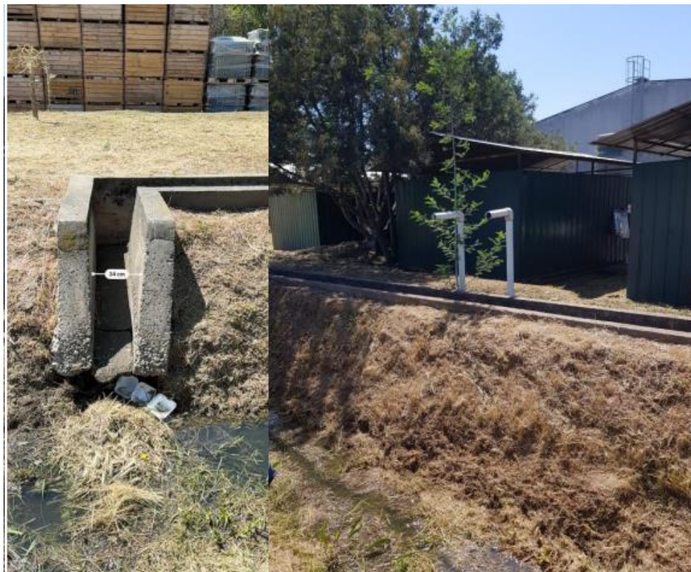
Fuente: Fotografías de visita a terreno, de fecha 24 de octubre de 2023.
