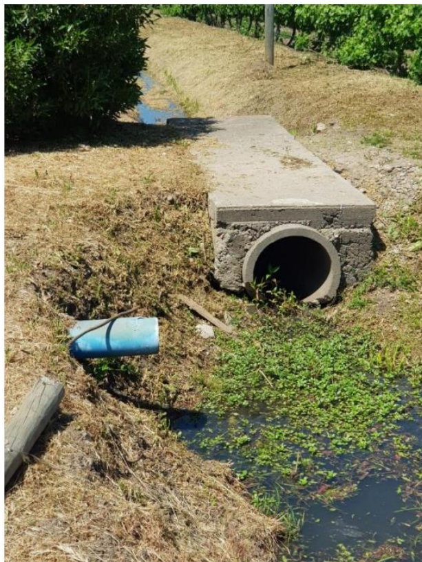
Fuente: Fotografías de visita a terreno, de fecha 24 de octubre de 2023.
