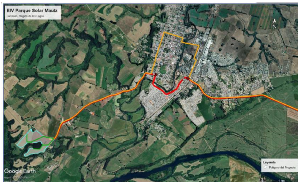
Imagen 1. Ubicación general de señales que obligan la dirección del tránsito de camiones.
