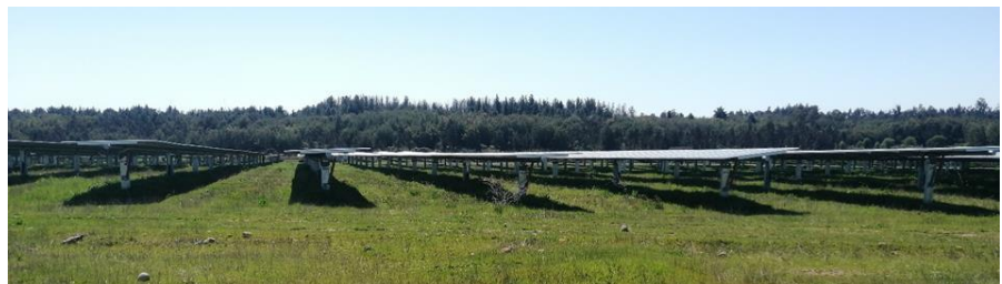
Figura 15: Condición de suelo en proyecto-sitio similar.
