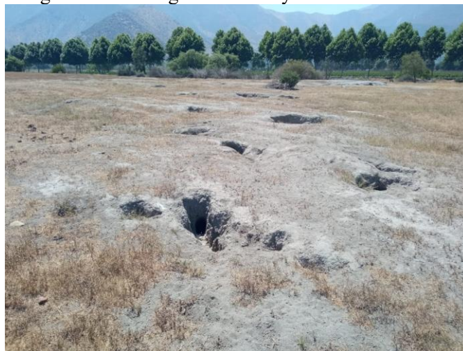
Figura N° 1: Fotografía cuevas y túneles del terreno.
