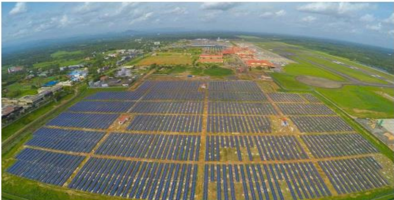
Figura 15. Vista de paneles instalados en el Aeropuerto Internacional de Cochin, ubicados de forma próxima la pista de aterrizaje.
