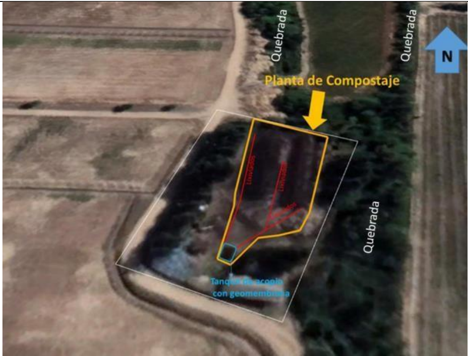
Figura 4: Planta de compostaje, tranque de acumulación de lixiviado.
