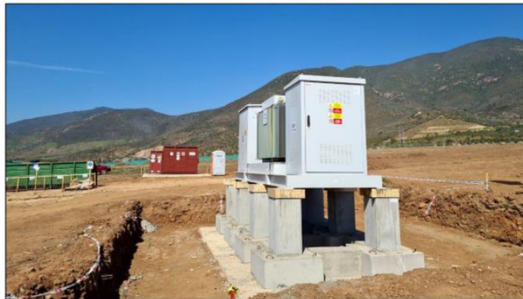
Figura 1-38. Referencia construcción de fundaciones de transformador.
