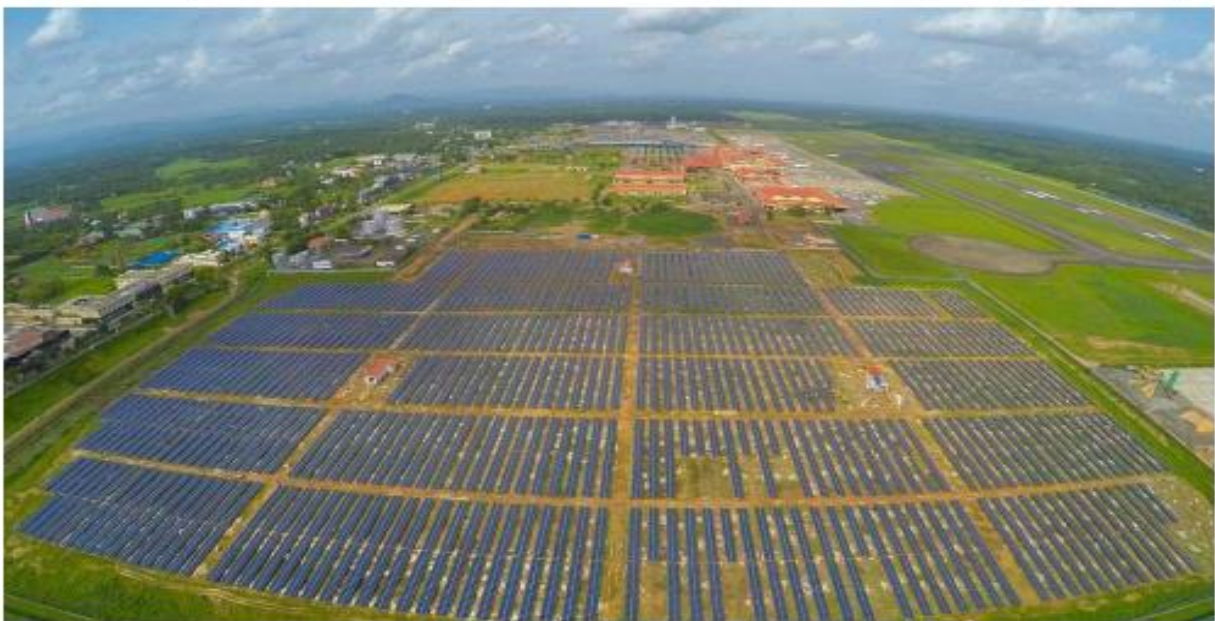
Figura 15. Vista de paneles instalados en el Aeropuerto Internacional de Cochin, ubicados de forma próxima la pista de aterrizaje.
