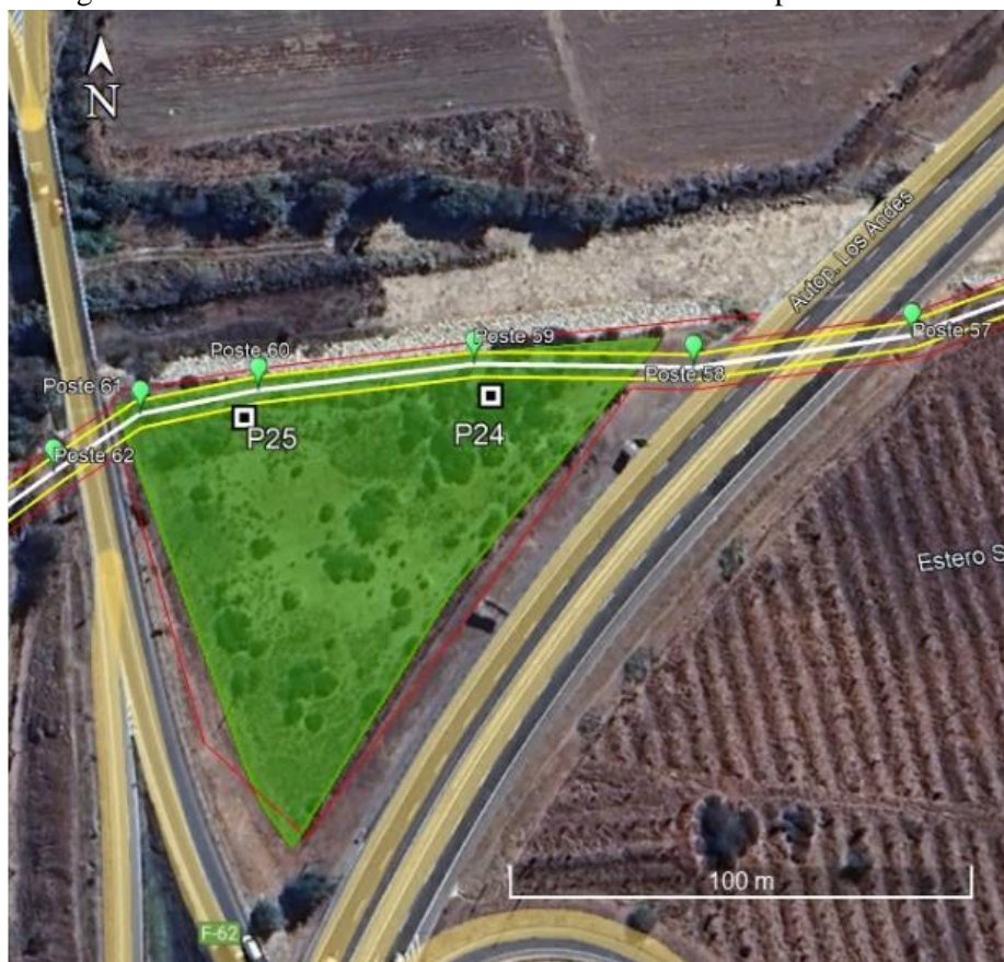
Figura 1: Tramo Línea de evacuación eléctrica entre los postes 58 al 61.
