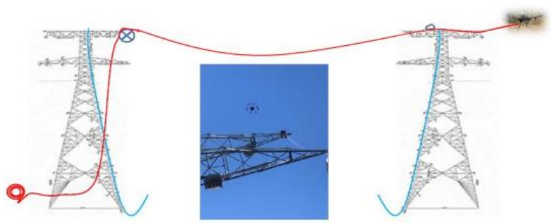
Fuente: Figura 4. Proceso de instalación del cable de tendido eléctrico con Dron, del Anexo 3 Actualización Predicción y Evaluación de Impactos, Adenda Excepcional.
