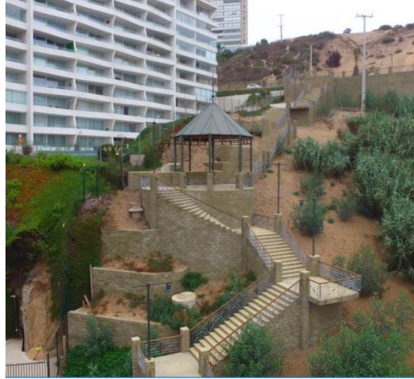
Figura 4.3.1.1.3: Escalera entre calle Cornisa y Av. Borgoño.
