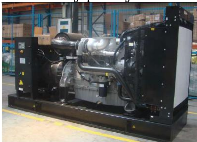
Figura 2.1 Motor interno de grupo electrógeno a utilizar en el Proyecto
