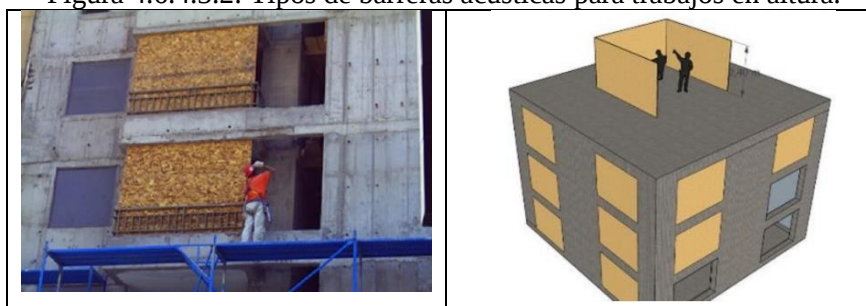
Figura 4.6.4.3.2: Tipos de barreras acústicas para trabajos en altura.
