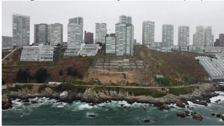
Figura: Vista al área del Proyecto desde el mar (dron).
