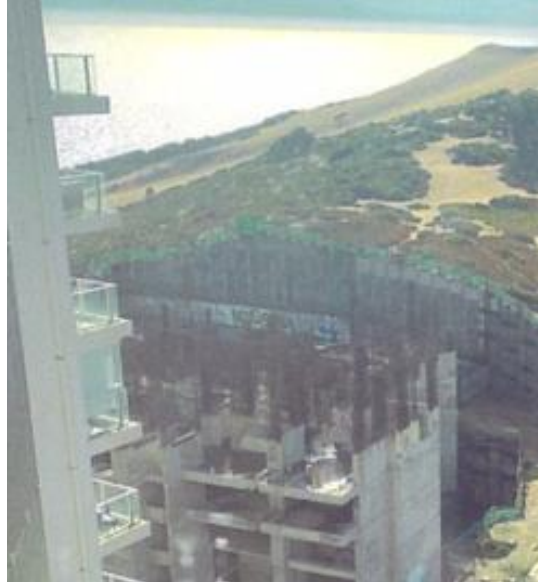
Figura 4, Obras edificio Alto Santorini en el ecosistema dunar.
