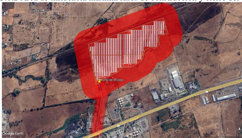
Figura 5.1.2 Área de influencia máxima fases de construcción y cierre del proyecto
