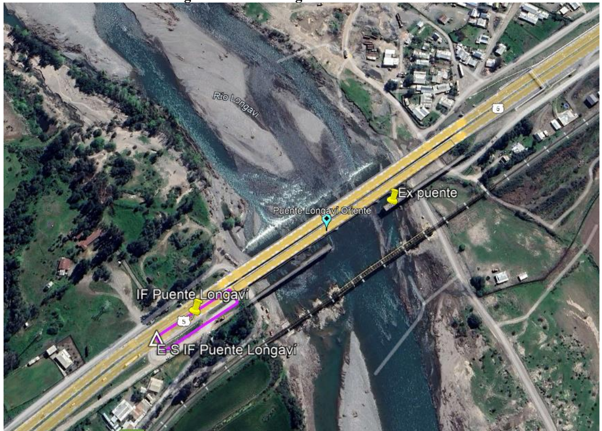
Figura: Puente Longaví Oriente
