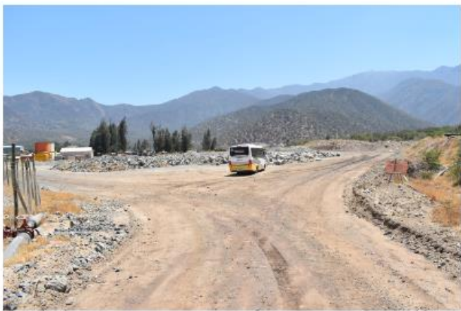
Fotografía N° 3 y N°4: Área destinada para la instalación de la piscina PAR II y piscina actual
