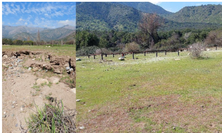
Figura 2. Erosión y desprendimiento de material en el sitio GH02 y estructuras construidas en el sitio GH01.
