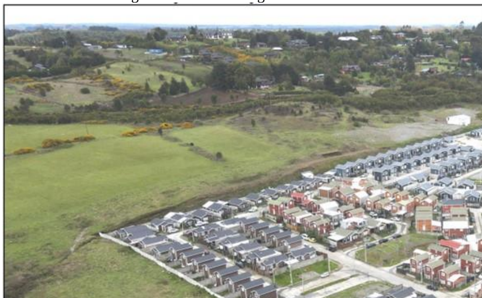
Figura 4.6.1.2.3. Vista general del terreno.
