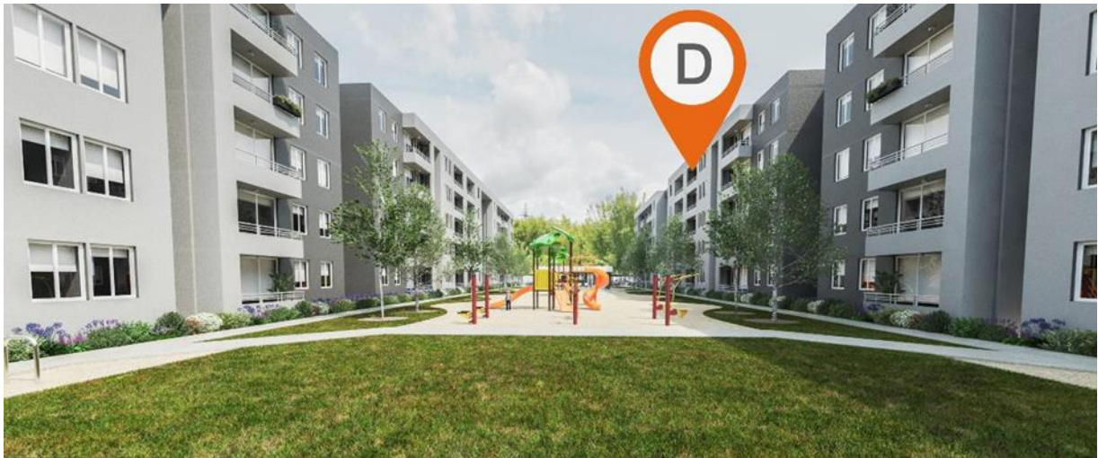
Fuente: Figura 26. Imagen de referencia en que se observan áreas verdes privadas, juegos infantiles y zona sport al interior del condominio. Fuente: Tour virtual del Proyecto Lote 2 https://lantano.cl/tour-virtual/ . Adenda Complementaria.
