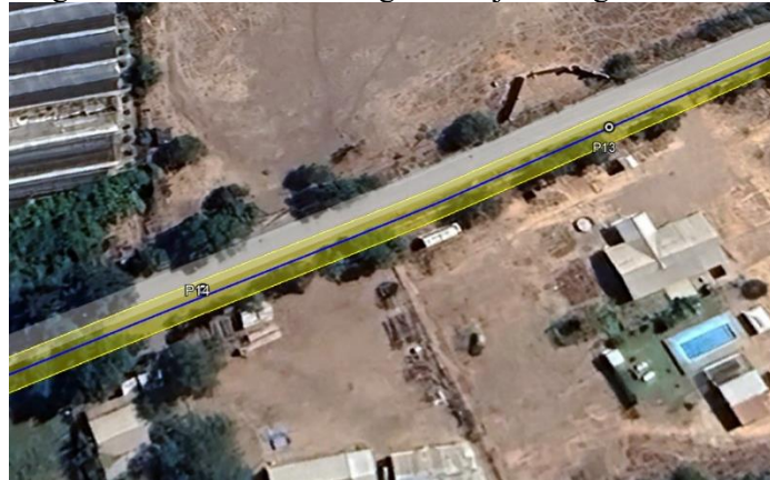
Figura 1.2: Viviendas contiguas a faja de seguridad LTE.
