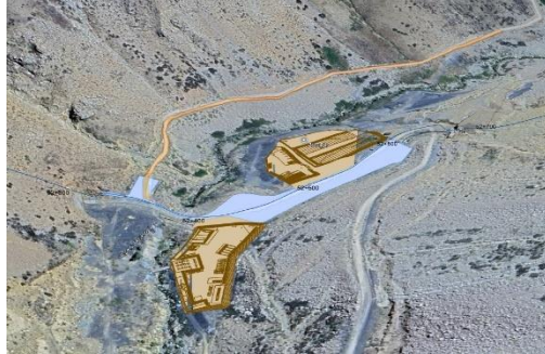
g) Instalación de Faena 5, colindante al Estero Riecillos
