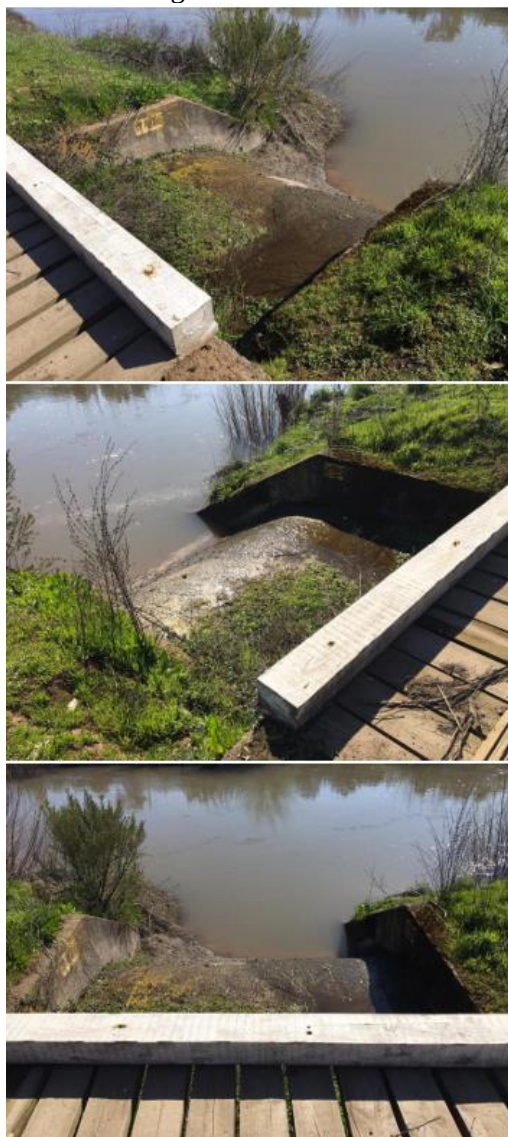
Figura N°13. Obra de descarga existente en Canal Teno – Chimbarongo.
