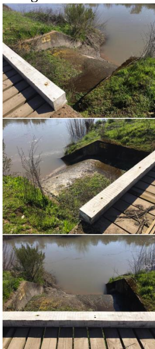
Figura N°4. Obra de descarga existente en Canal Teno – Chimbarongo.
