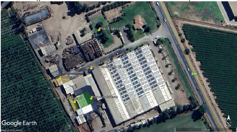
Figura 4.7.5.4.2: Ubicación focos emisores de olor de la planta.
