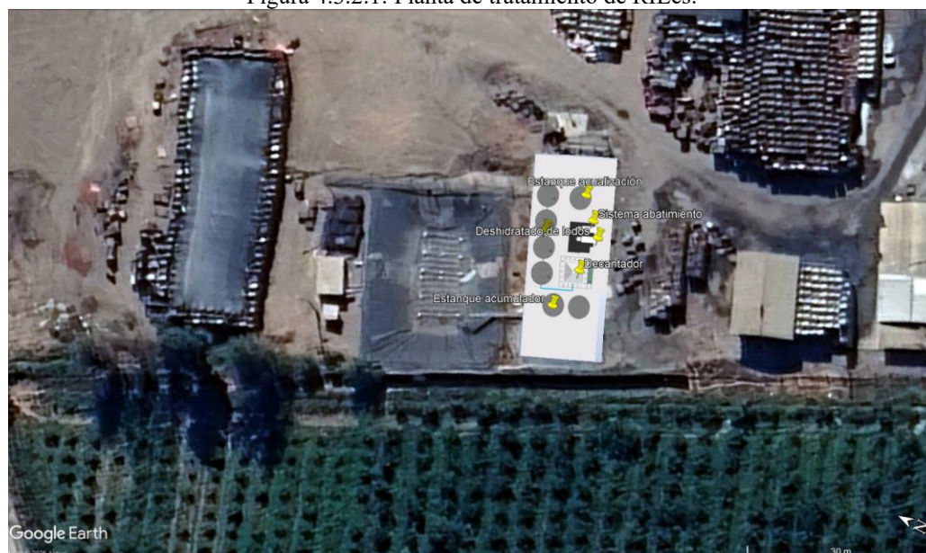
Figura 4.3.2.1: Planta de tratamiento de RILes.
