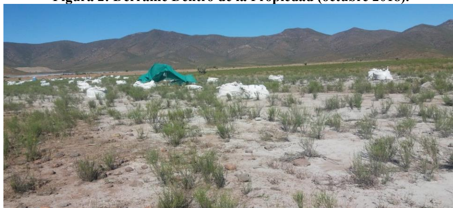
Figura 2: Derrame Dentro de la Propiedad (octubre 2018).
