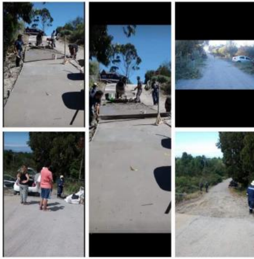
Figura 16: Pavimentación del camino desde la Ruta principal a Panitao Bajo
