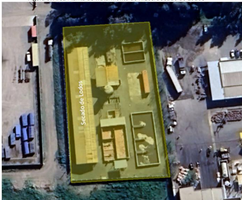
Figura 5: Área Planta de Tratamiento de RILes/Secado de Lodos
