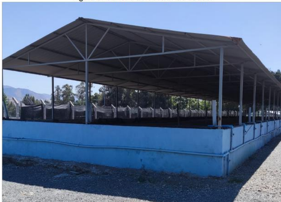
Figura 9: Cancha de Secado de Lodos.
