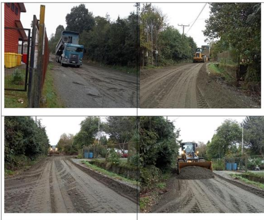
Figura 22. Arreglo de camino desde posta de Panitao alto hasta camino costero Panitao Bajo
