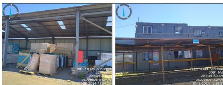
Sector con obras asociadas al Proyecto colindante: bodegas y oficinas
