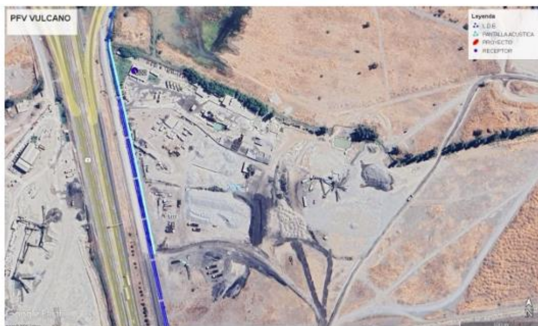
Imagen 8: ubicación pantalla acústica, escenario 1, Construcción LDE y zanja. Receptor V22
