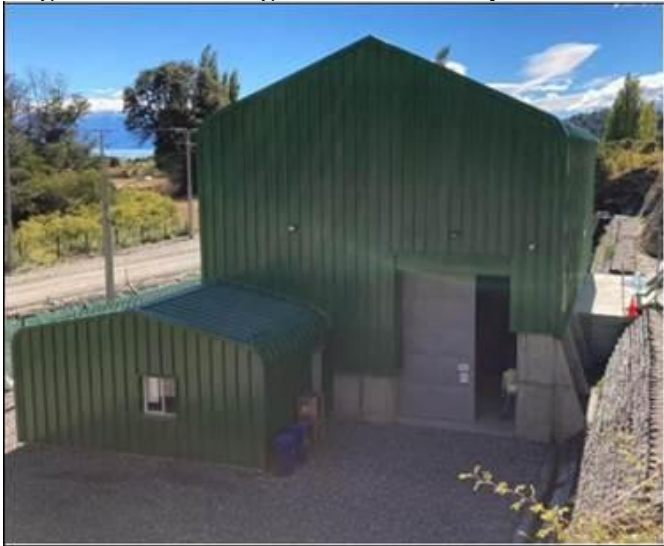
Figura 4.2.16.: Fotografía casa de máquinas actual.
