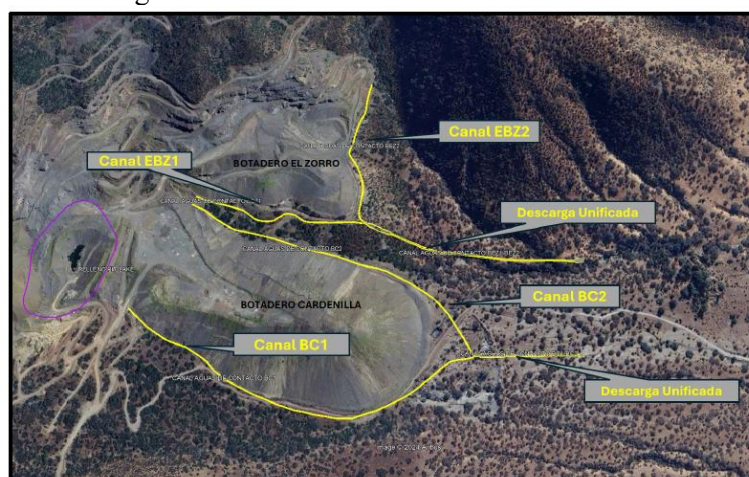
Figura 6.2.2.3: Canales de contorno botaderos.
